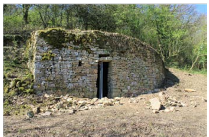
Après les travaux
